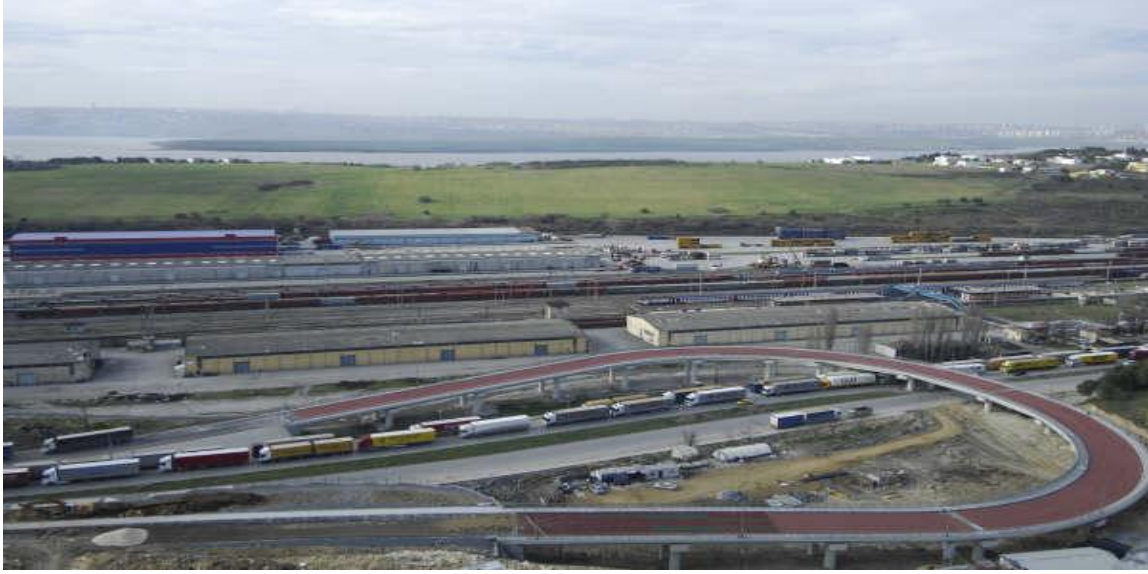
Resim 1: Yapımı Tamamlanmış Bir Lojistik Merkez
