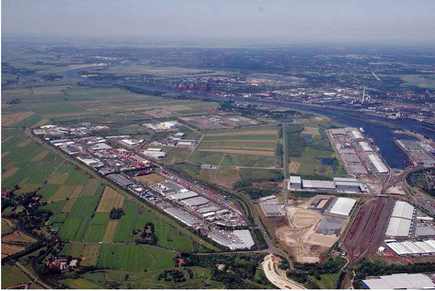
Resim 4: Yapımı Tamamlanmış Bir Lojistik Merkez
