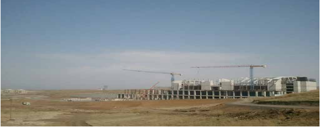
Resim 2.3 Ağrı Havalimanı Terminal Binası İnşaatı
