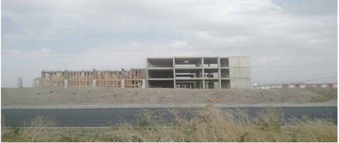
Resim 2.4 Ağrı Devlet Hastanesi İnşaatı
