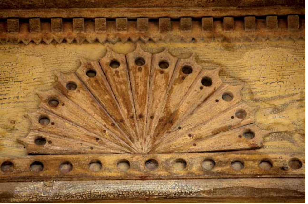
Çakmak köyünde Malakan evinde pencere detayı.
