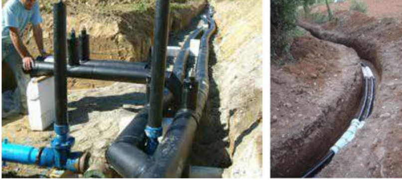
Fotoğraf 36 Isıtma borularının yer altına döşenmesi
