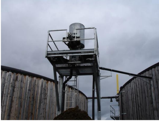
Fotoğraf 48 Sindirilmiş bulamacı katı ve sıvı kısımlarına ayıran seperatör ünitesi
