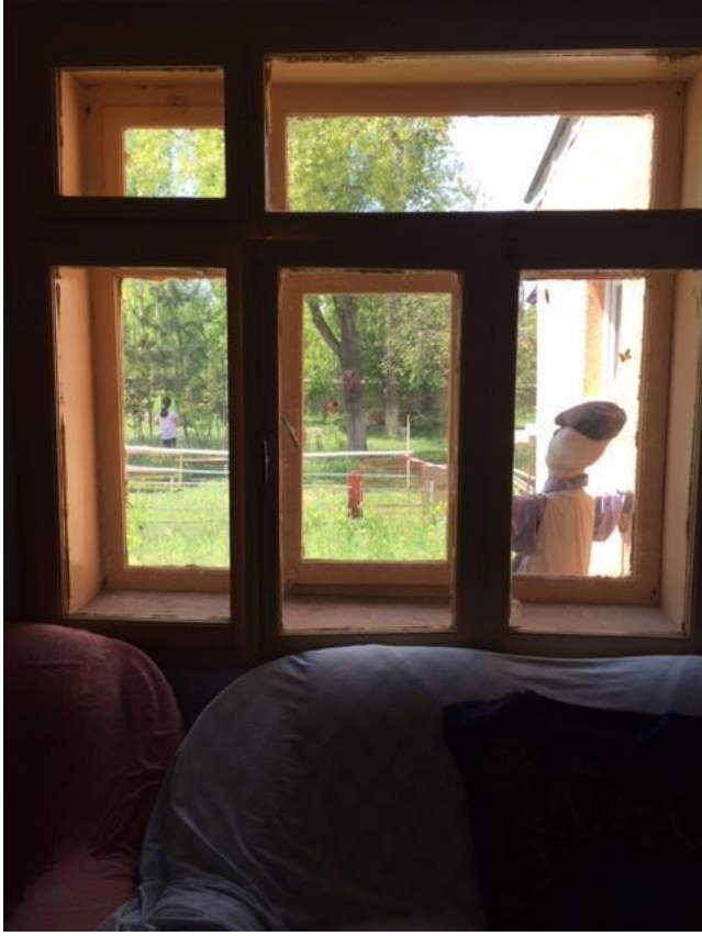
Fotoğraf 3 Duvar kalınlığının iki tarafına iki ayrı ahşap doğrama yapılarak ısı yalıtımı iyileştirilmiş.
