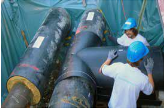
Fotoğraf 37 Çaplı ısıtma boruları montajı
