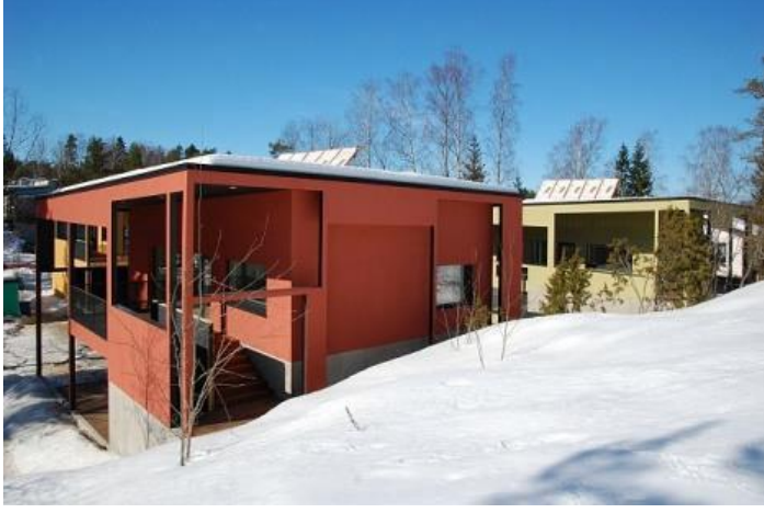
Fotoğraf 31 Finlandiya, Helsinki yakınlarında müstakil pasif evler
