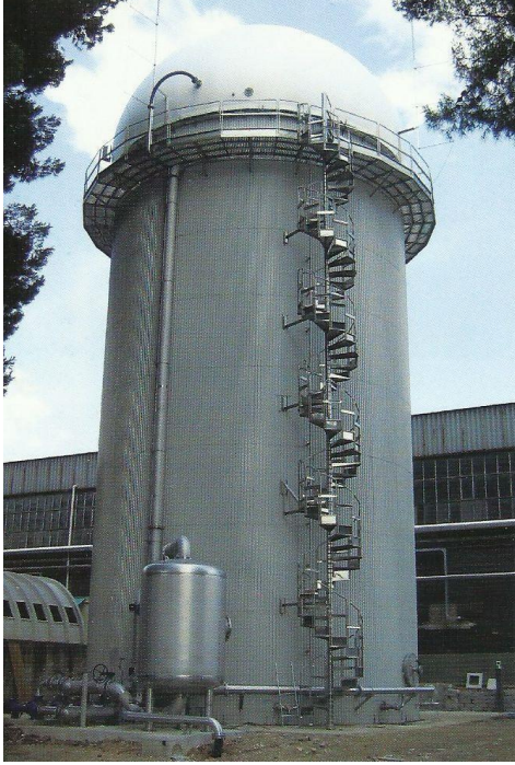
Fotoğraf 40 Biyogaz çürütücü tankı ve üzerinde yarın küre formunda biyogaz depolama ünitesi
