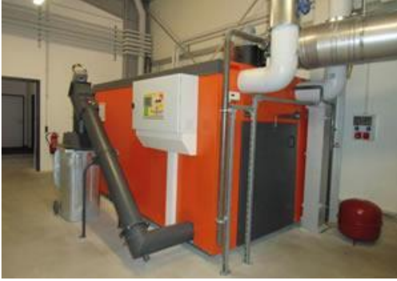
Fotoğraf 38 Heizomat RHK – AK serisi biyokütle doğrudan yakma ünitesi
