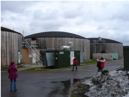
Fotoğraf 43 Çürütücüler ve önce kojenerasyon ünitesi
