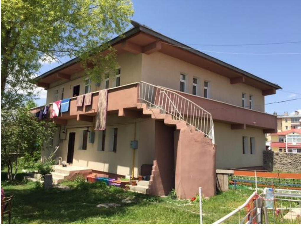
Fotoğraf 5 2002 yılında inşa edilen 2013 yılında mantolama yapılan her katında bağımsız birer daire bulunan 2 katlı yapı
