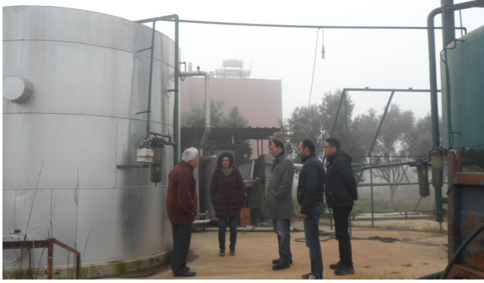
Resim 13: Torbalı ev tipi biyogaz tesisi 2
