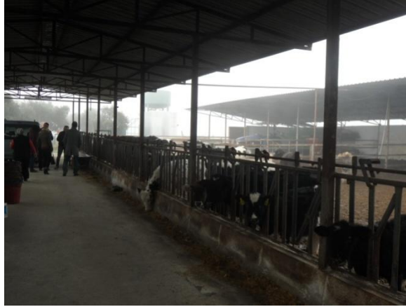
Resim 12: Torbalı ev tipi biyogaz tesisi
