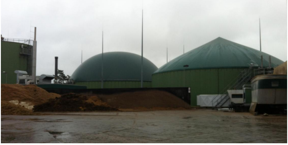
Resim 17: Arka planda üzerlerinde gaz depolama üniteleri ile çürütücü tanklar ve paratonerler. Ön planda ; mısır silajı ve buğday silajı (beyaz), ortada altlık saman ile karışık dışkı.
