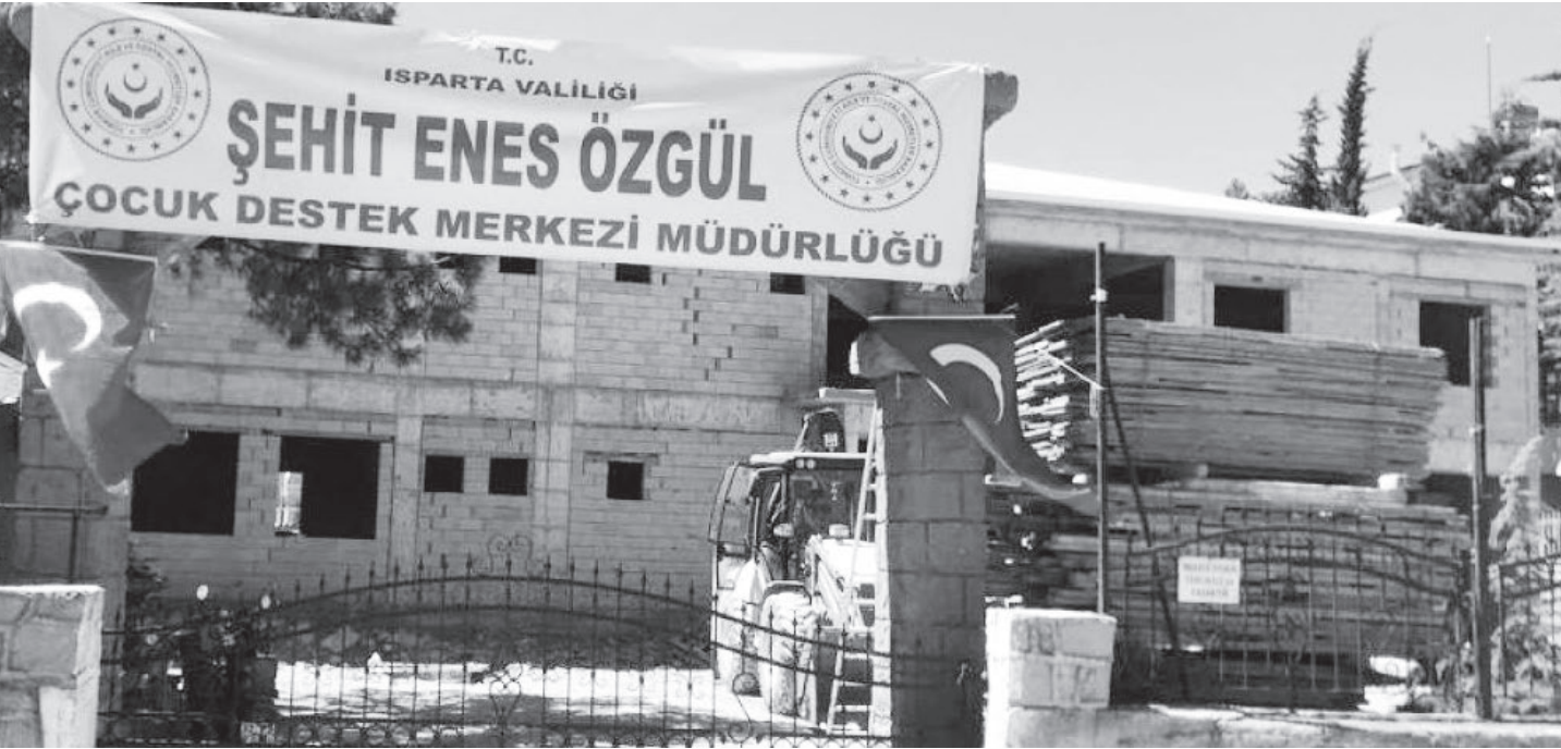
Isparta'nın Piri Mehmet Mahallesi'nde yapımı süren merkezin inşaatının girişine "Şehit Enes Özgül Çocuk Destek Merkezi Müdürlüğü" pankartı asıldı. (FOTOĞRAFLAR: DHA-AA)
