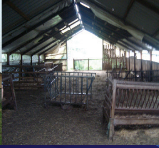
Koyun bannağı (içten görünüşü)
